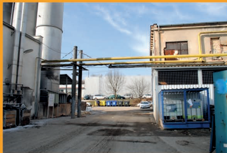
Zranitelná část plynovodu – nalevo moučná síla, napravo (mimo foto) regul. stanice plynu.
