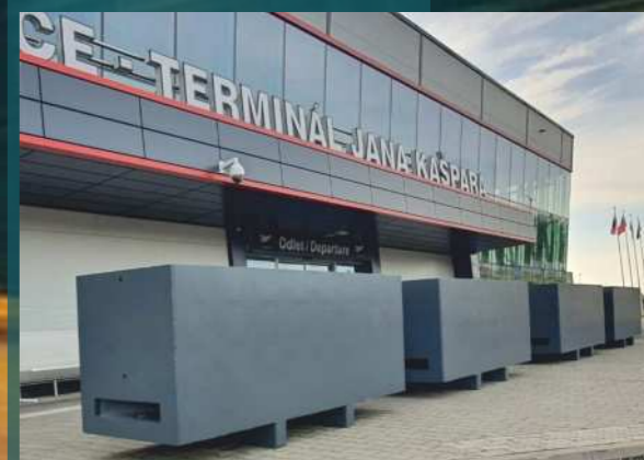
7. Květinové boxy na mezinárodním letišti Pardubice. Vysoká schopnost pohlcovat náraz, zachytit střely i fragmenty a zastavit vozidlo N3 (7,5 t) při 80 km/h; poskytuje místo pro krytí a přebíjení zasahujícím jednotkám a ochranu kritických míst.
